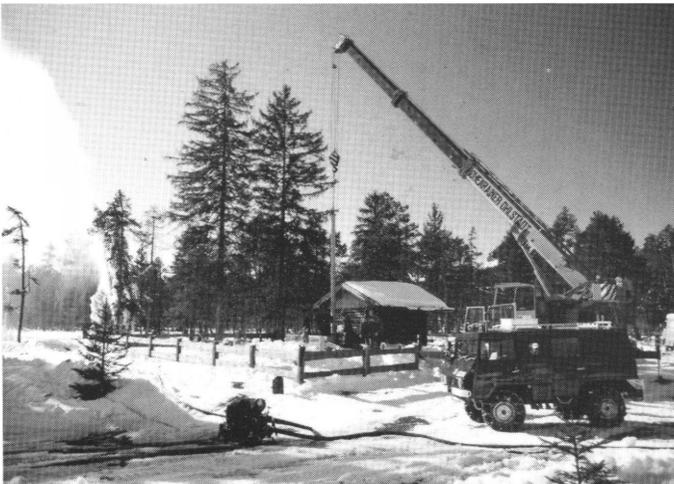
Am 18. 2. und 19. 2. 91 wurde in einem 36 stündigen Einsatz die Wasserversorgung von Krün sichergestellt. Eine 1,5 km lange Schlauchleitung mit 3 Pumpen, TS 8/8, förderte das Trinkwasser vom Tiefbrunnen der Gemeinde Wallgau in das Krüner Netz und von dort zum Hochbehälter.
